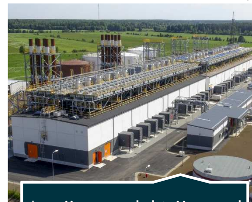
Avariireservelektrijaamad ja 145 alajaama
